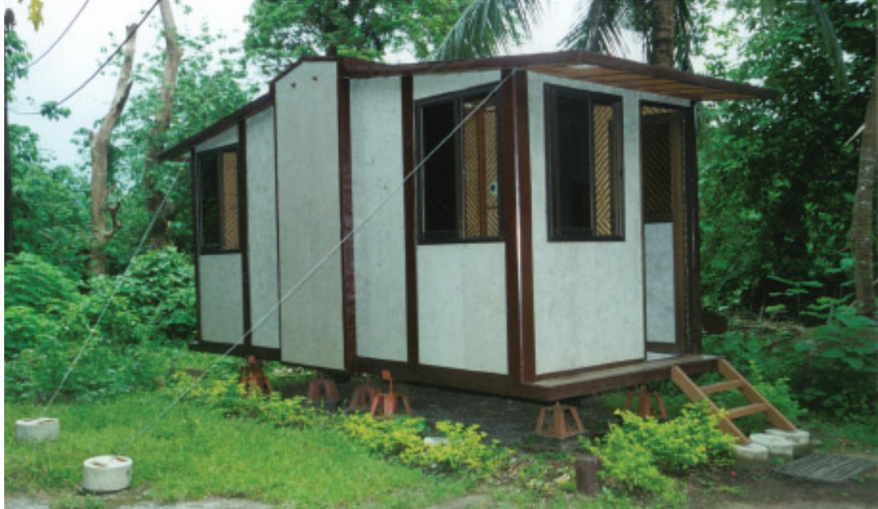
Un gîte confortable: la maison F entièrement érigée. Elle est assujettie au moyen de câbles tendus attachés à des blocs d'ancrage au sol.
