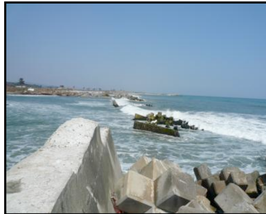
被災した防潮工(亶理郡山元町)
