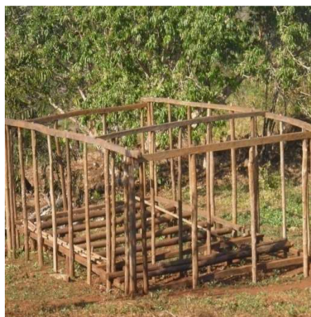
Photo 1: Construction en bois précieux
