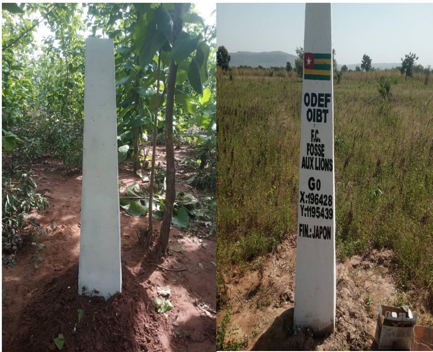
Travaux de peinture
