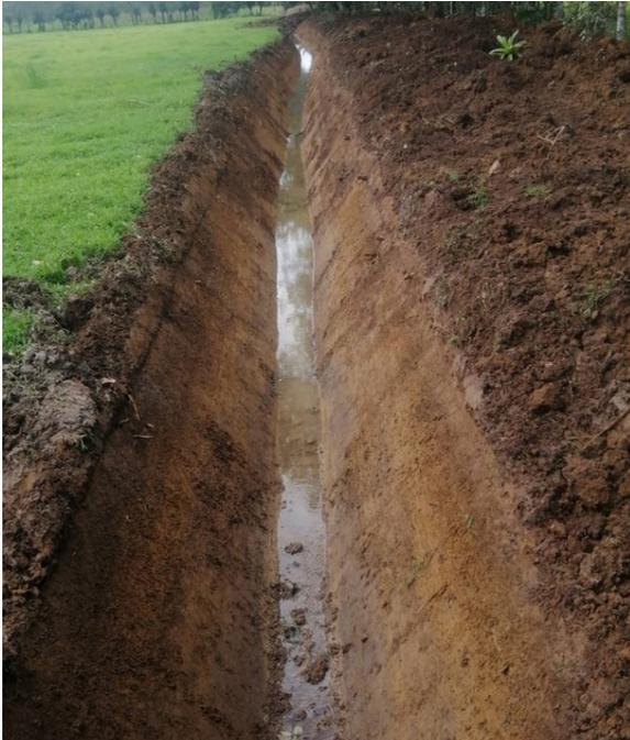
**Figura 3.** Drenaje primario para mejorar la salida del agua en plantaciones en zonas bajas muy húmedas, zona norte de Costa Rica.
