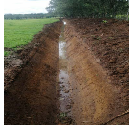
Figura 3. Drenaje secundario en finca de zona baja con problemas de encharcamiento de agua, Zona Norte de Costa Rica.
