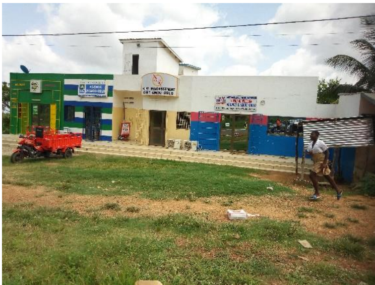
Photo 6. Immeuble abritant les agences de la CEET et TdE à Amou-Oblo
