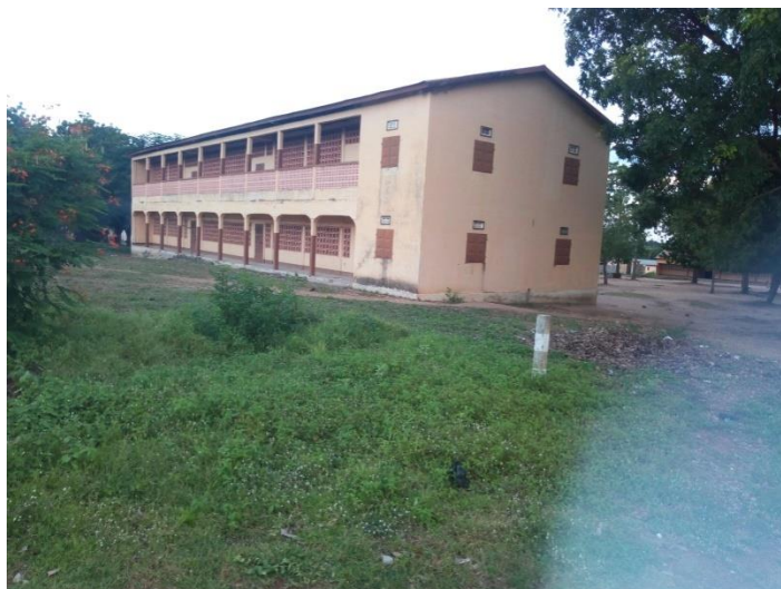
Photo 31. Bâtiment d'un Lycée à AKPARE
