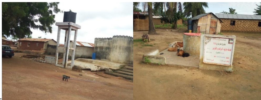
Photo 8. Forage et puits
