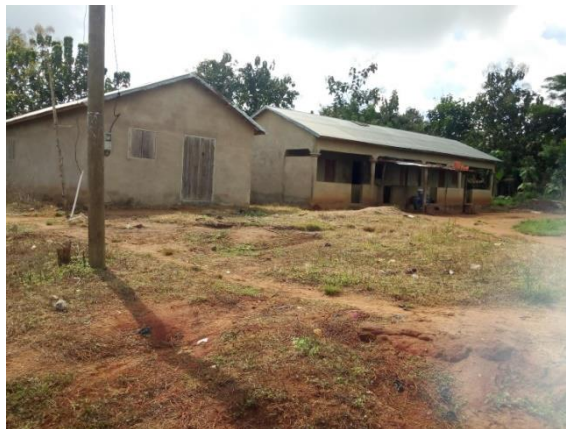
Photo 4. Maison en dur à toiture en tôle
