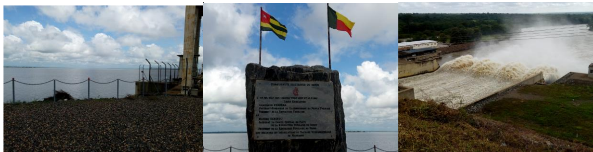
Photo 6 : Barrage de Nangbéto dans la préfecture de l'Ogou Source : Consultant, 2019
