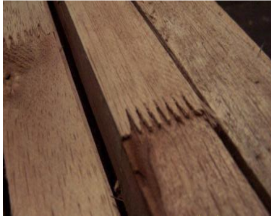
Photo 36 (S. Y. Kim): Des languettes et rainures incompatibles
