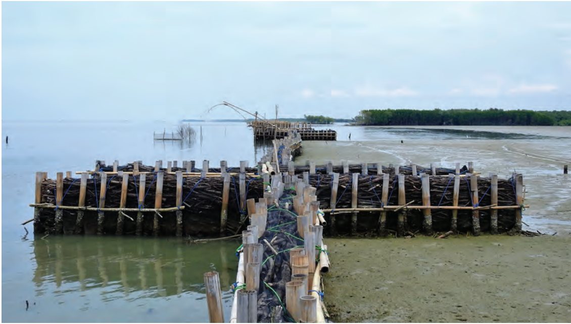
Un mur ajouré: Le but de ce piège à sédiments poreux érigé dans le cadre du projet Building with Nature à Demak en Indonésie est de créer un habitat propice à la régénération naturelle de la mangrove. Photo: Yus Rusila Noor
