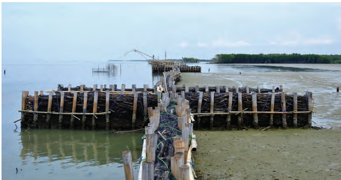
El muro de los milagros: El objetivo de esta barrera permeable construida por el proyecto Building with Nature en Demak, Indonesia, es crear un hábitat propicio para la regeneración natural del manglar. Fotografía: Yus Rusila Noor
