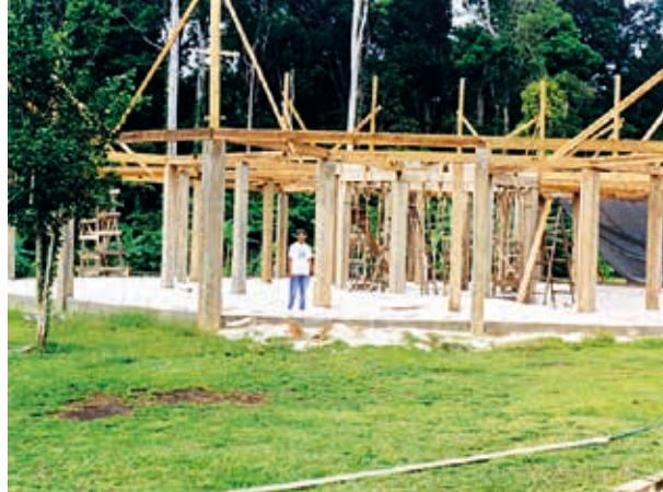
Cette station forestière dans la forêt d'Iwokrama (Guyana) est construite suivant les principes de la construction verte. Photo: Centre international d'Iwokrama
