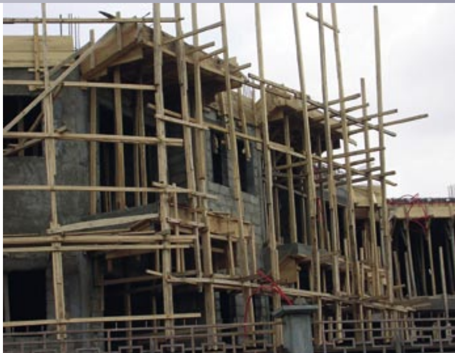
Pour le bâtiment: Utilisation du bois dans la construction au Cameroun. Photo: P. Langbour
