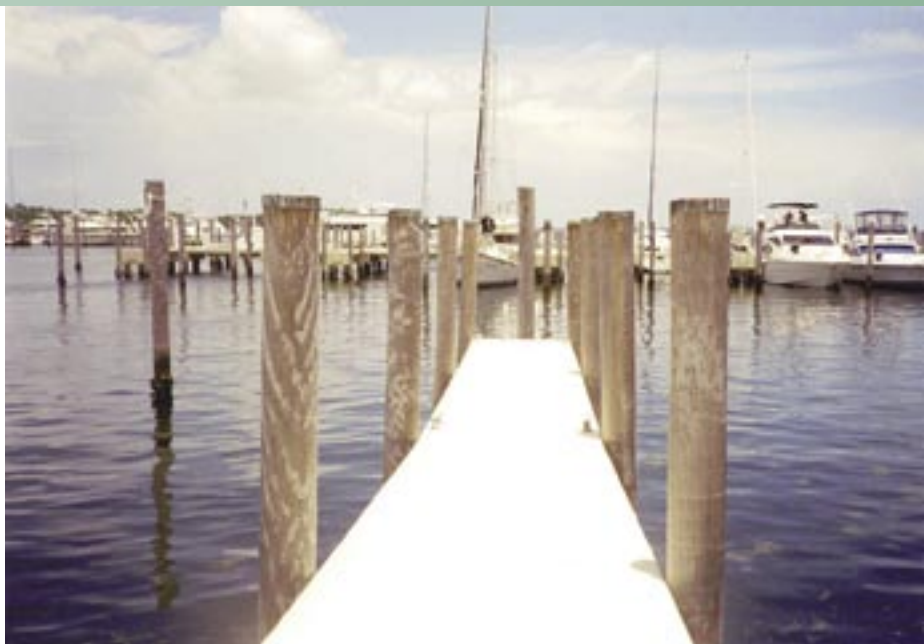
El próximo será de EMU: Pilotes de laurel de Guyana en un muelle de Miami (EE.UU.). Fotografía: Demerara Timbers Limited
