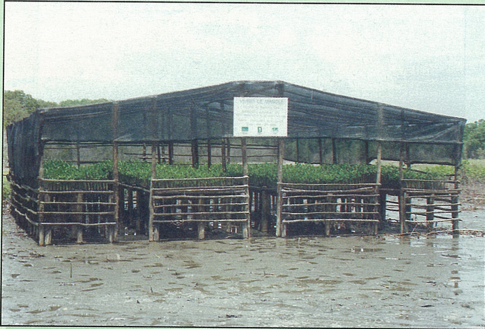
MODELO DE VIVERO PALAFÍTICO SEMIPERMANENTE IMPLEMENTADO POR EL PROYECTO EN ESTA FASE PARA LAS DIFERENTES LOCALIDADES, 1998
