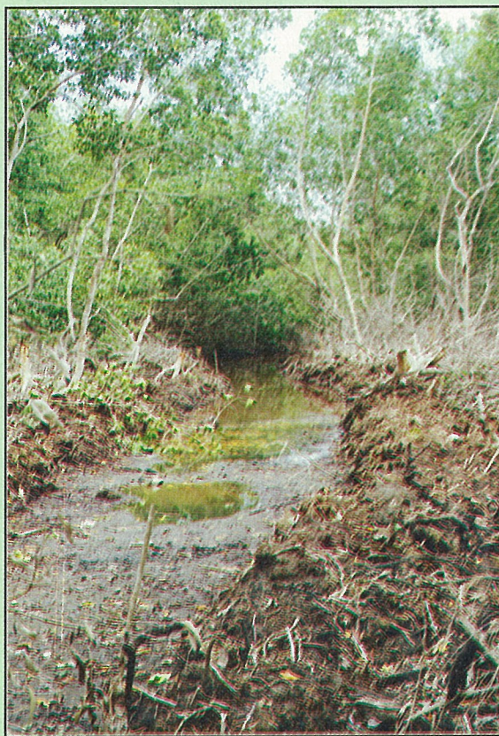
APERTURA DE CAÑO NUEVO DE LA CIÉNAGA DE LA MUERTE, POR PARTE DE LAS COMUNIDADES DE LA BAHÍA DE CISPATÁ (CÓRDOBA), 1998.
