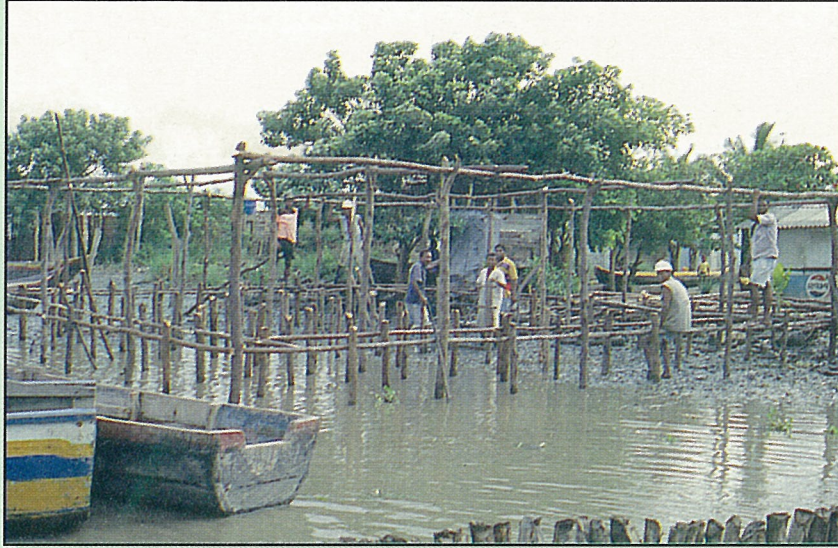
CONSTRUCCIÓN DEL VIVERO SEMIPERMANENTE POR PARTE DE LA COMUNIDAD DE PASACABALLOS (BOLÍVAR) Y EL APOYO DEL PROYECTO MANGLARES DE COLOMBIA. 1998
