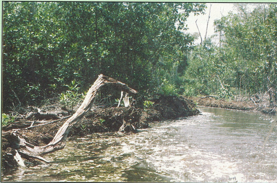
CAÑO DAGO DESPUÉS DE SU LIMPIEZA Y RECTIFICACIÓN. BAHÍA DE CISPATÁ (CÓRDOBA), 1996.
