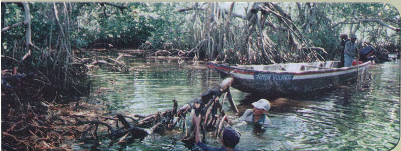
Mantenimiento y limpieza de caños por la comunidad de mangleros
