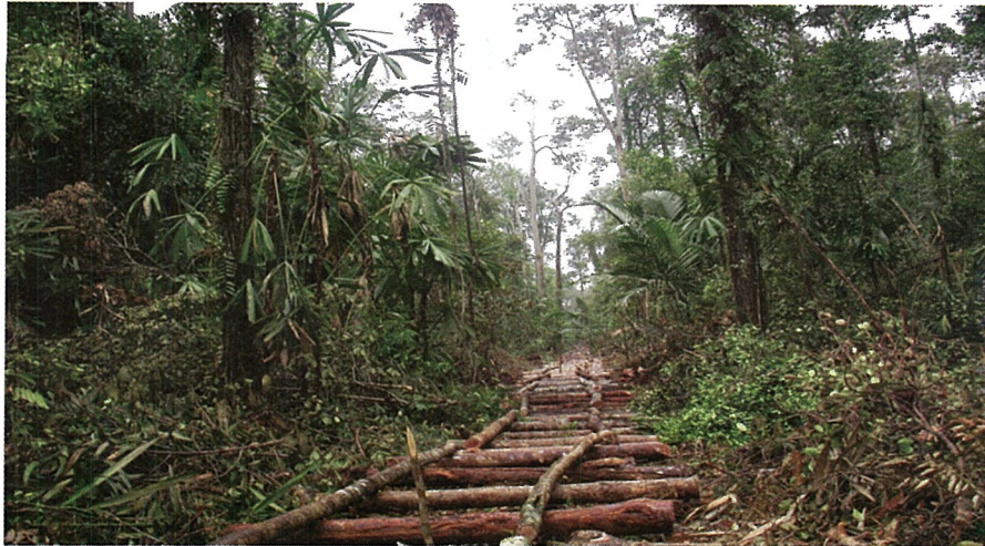
Gambar 6. Persiapan pembuatan jalan rel.
