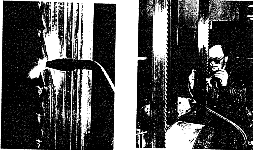
Gambar 9. Teknik pengelasan mata gergaji pada band saw blade
