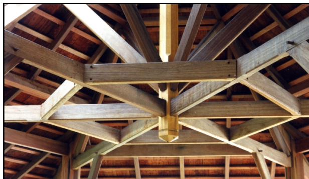
Charpente traditionnelle en Basralocus – Bardeaux en Wapa (© M. Vernay)
