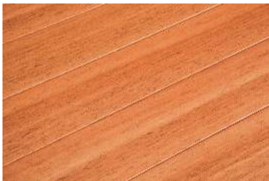
Piso envernizado / acabado Varnished/finished flooring
