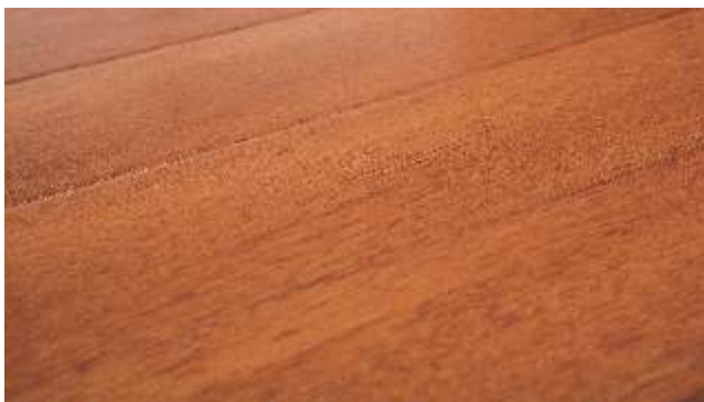
Piso envernizado / acabado Varnished/finished flooring
