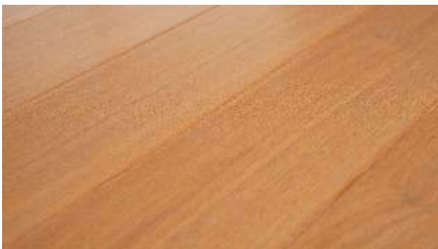
Piso envernizado / acabado Varnished/finished flooring
