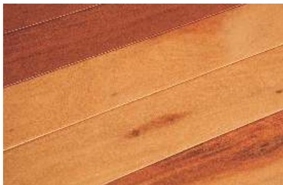
Piso envernizado / acabado Varnished/finished flooring
