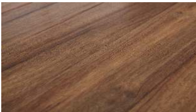
Piso envernizado / acabado Varnished/finished flooring
