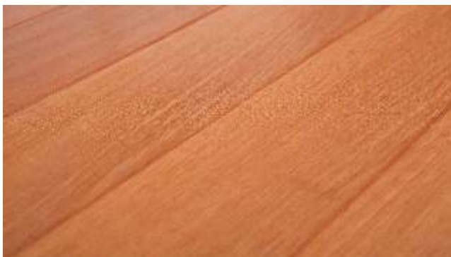
Piso envernizado / acabado Varnished/finished flooring
