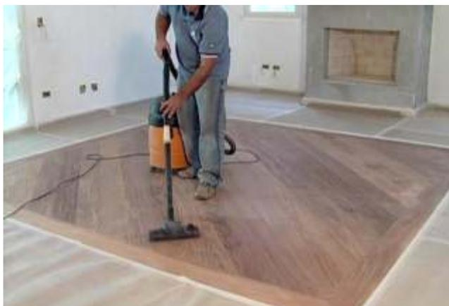
**Figura 45.** Limpeza do piso com aspirador de pó.
