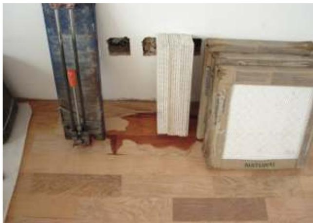
**Figura 71.** Falta de proteção total do piso de madeira durante reforma do imóvel.
