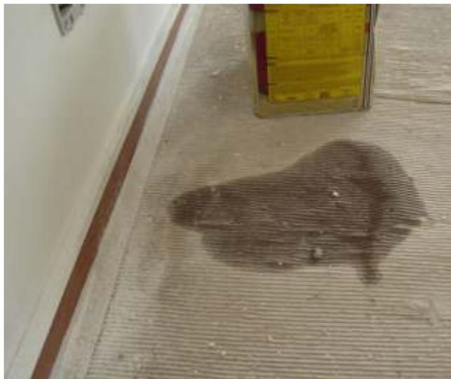
**Figura 70.** Proteção insuficiente do piso durante a reforma do imóvel.
