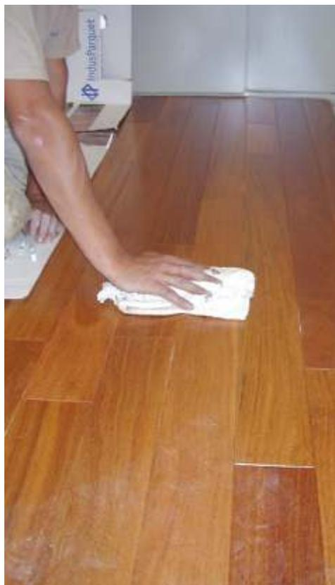
**Figura 36.** Limpeza do piso após instalação.
