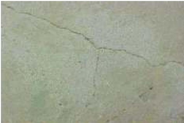
**Figura 17.** Trincas de cura no contrapiso.
