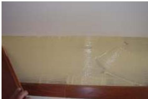
**Figura 32.** Adesivo espalhado pronto para receber o piso de madeira.
