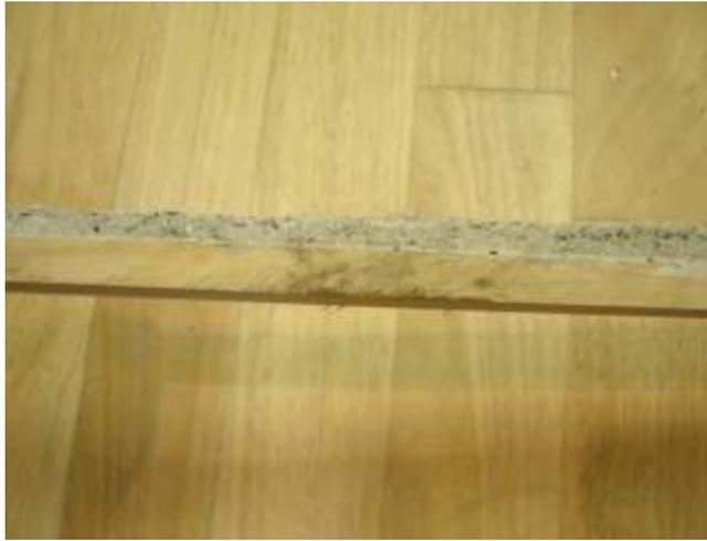
**Figura 60.** Camada de regularização sem aderência à base.
