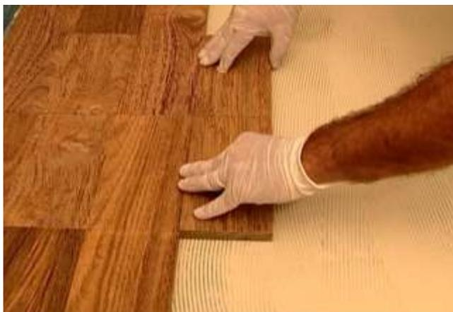
**Figura 34.** Montagem e fixação do piso de madeira utilizando adesivo.
