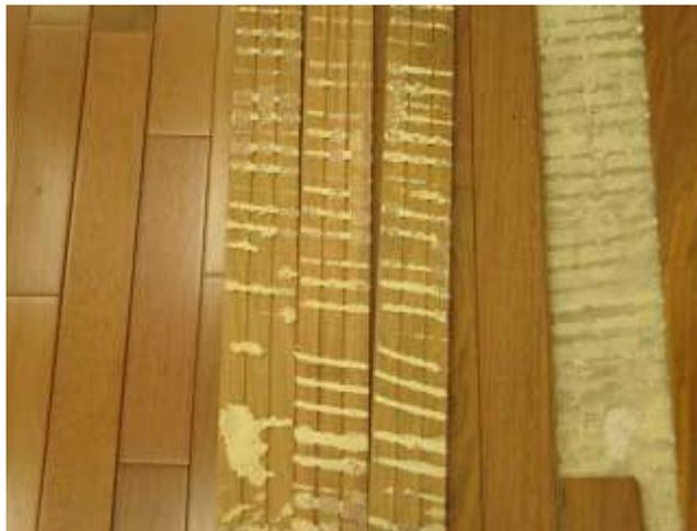
**Figura 62.** Má distribuição do adesivo na régua.
