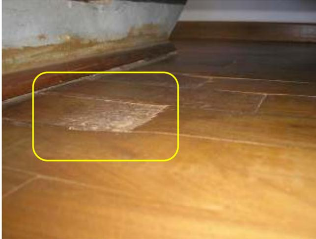
**Figura 65.** Lixamento imperfeito, piso mal acabado.
