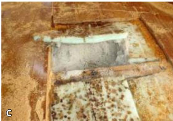
**Figura 59.** Problemas causados pela absorção de umidade.
