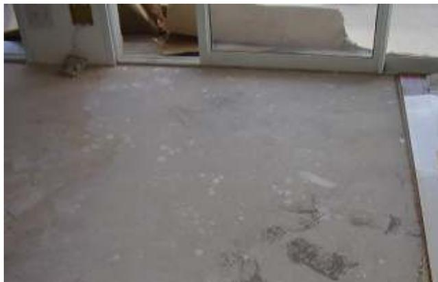
**Figura 30.** Contrapiso sem impermeabilizante.
