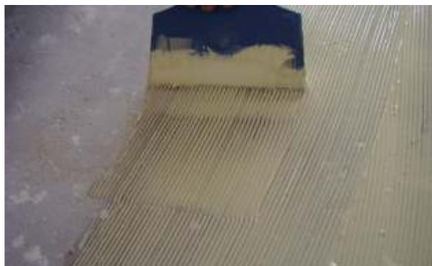
**Figura 25.** Aplicação de adesivo PU.
