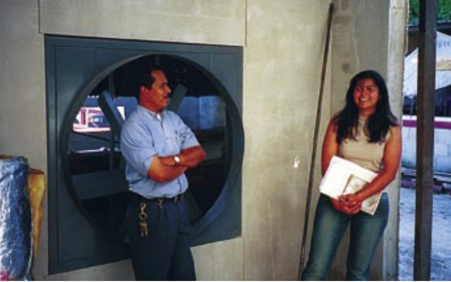
Perspectiva brillante: Heidy Vides de ESNACIFOR conversa con un miembro de la cooperativa de San Pedro de Sula, al lado de un horno de secado solar que se encuentra en fase de construcción.
