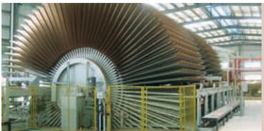
Sistema de refrigeración de tableros de fibra en una empresa maderera de Hongtai, China. Fotografía: J. Claudon, OIMT
