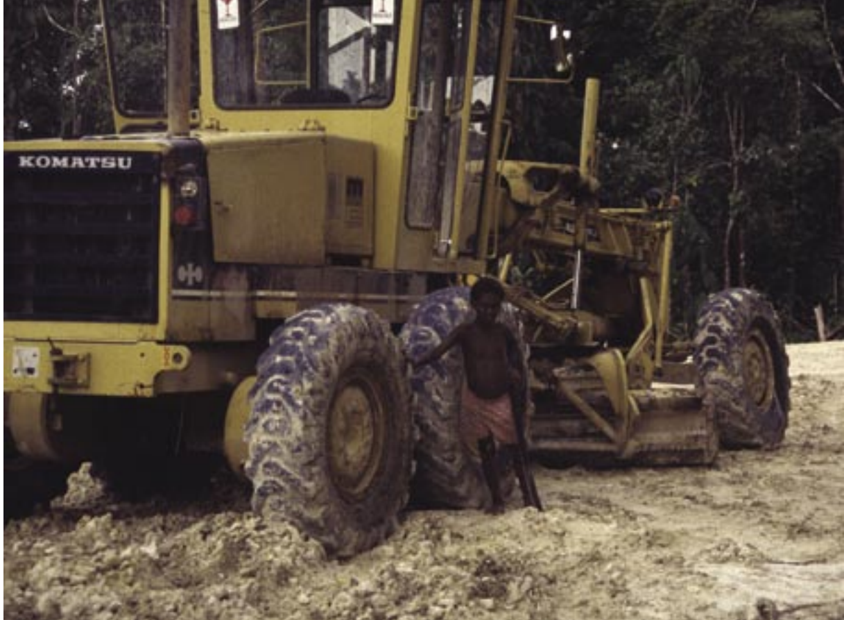
Nivellement? Les fonds accordés par les gouvernements pour la construction de routes d'exploitation peuvent être considérés comme une subvention. Photo: A. Sarre
